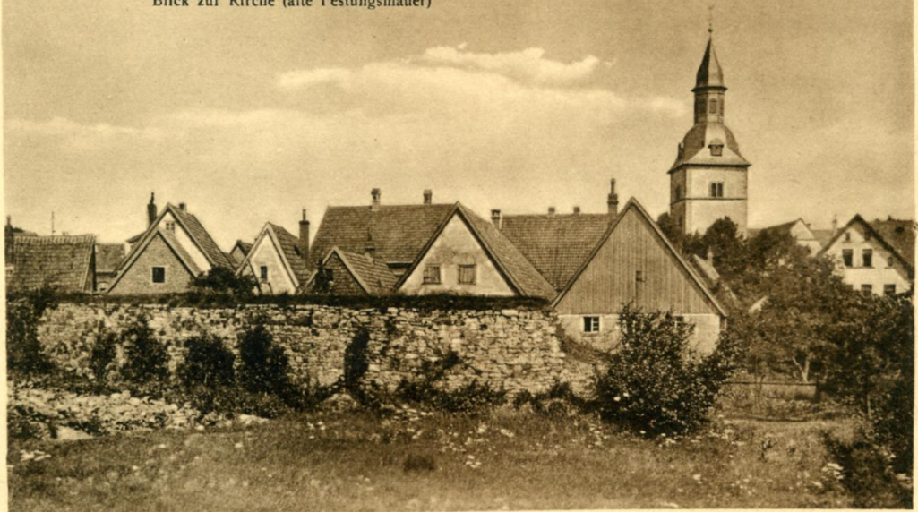
HORN (Teutobg. Wald) Blick zur Kirche (alte Festungsmauer)
